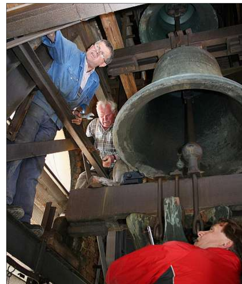
Pünktlich: Damit die Glocken zu jeder Viertelstunde und jeder vollen Stunde läuten können, montierten Peter Helfer (v.l.) und Alois Greilinger die Glockenschläger.
