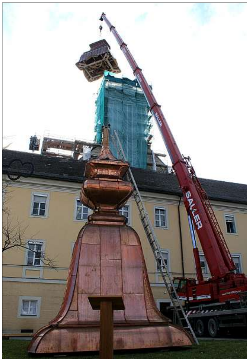
In schwindelnder Höhe baumelte die obere Turmzwiebel am Kran...
