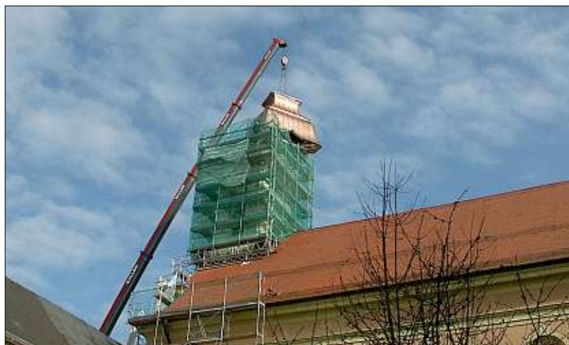
...bevor sie vorsichtig auf den Turmstumpf abgeseht und auf der Mauerkrone befestigt wurde.
