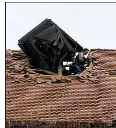
Erste Reparaturarbeiten der Zimmerer am Dach dauerten gestern den ganzen Tag.
